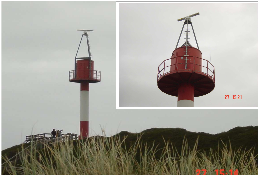
Abbildung 15: Das WAMOS-Seegangsradar auf dem Unterfeuer in Hörnum.
